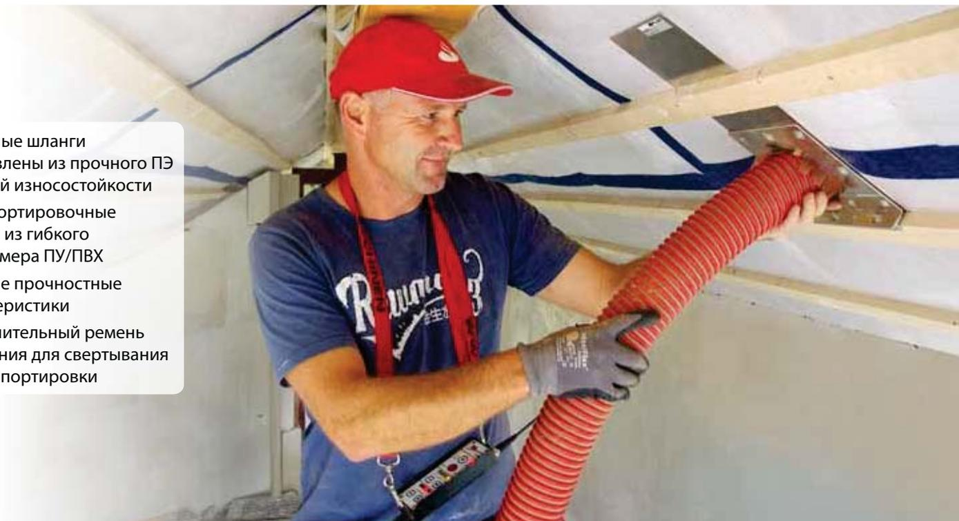
Профессионалы в сфере выдувных технологий различают выдувные и транспортировочные шланги. Для выдувных шлангов выделяют две степени жесткости: Красные выдувные шланги (1) немного менее эластичные по сравнению с синими (2). Оба вида хорошо подходят для выдувки в коробчатые конструкции. Их гибкость позволяет эффективно обходить барьеры и препятствия внутри задуваемых полостей.
