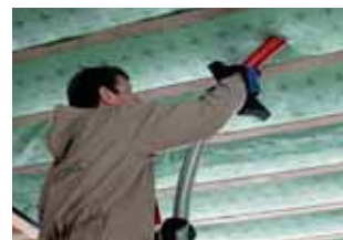
Монтажник, утепляющий подкровельное пространство при помощи выдувной иглы.
